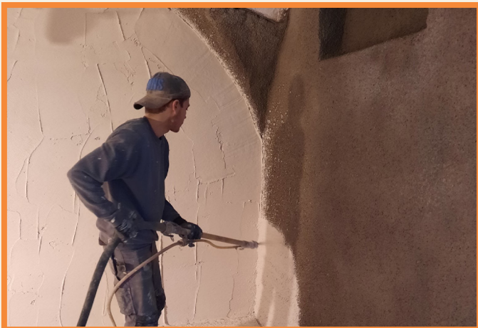
Renovatie van de gewelvenkelder tijdens verplichte sluiting wegens Covid19
